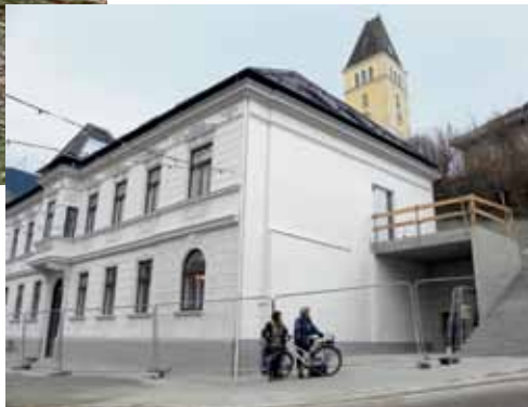
Neue Radabstellanlagen und Radgarage Rathaus
