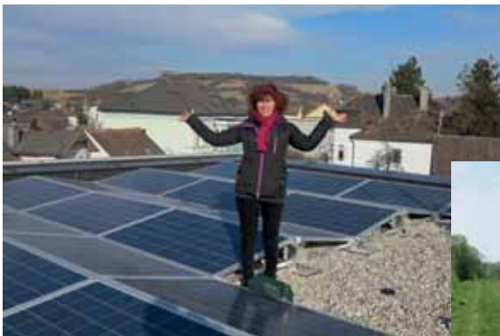
Photovoltaik auf öffentlichen Gebäuden mit Bürgerbeteiligung
