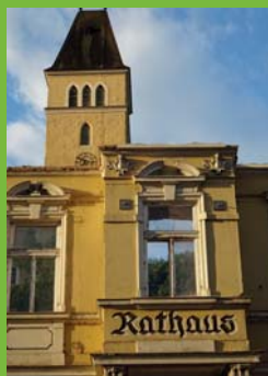
Das denkmalgeschützte Rathaus wird saniert!
